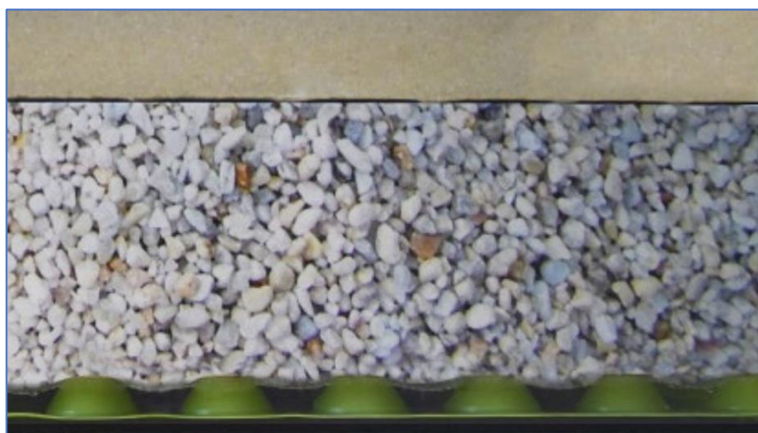
Fig. 3.1. – Membrana drenante (in verde) sottomassetto.
