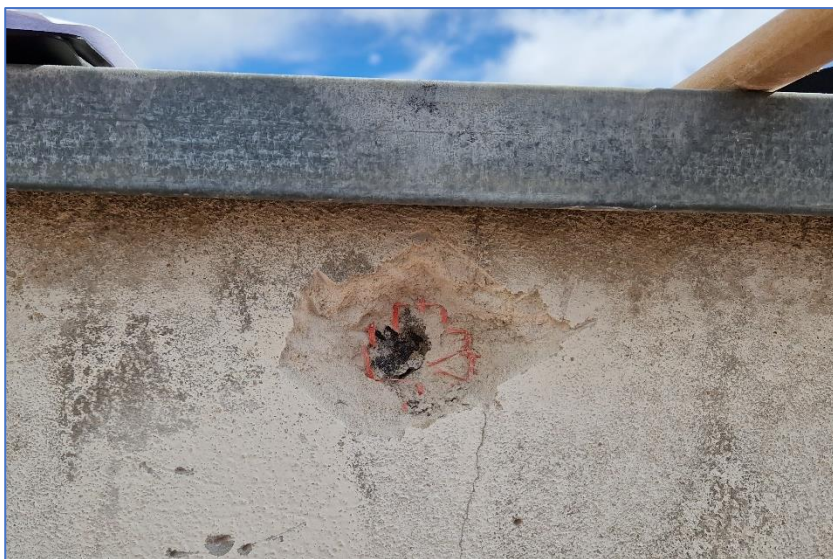
Fig. 0.2.7. – Intonaco, rete portaintonaco e guaina sui parapetti.
