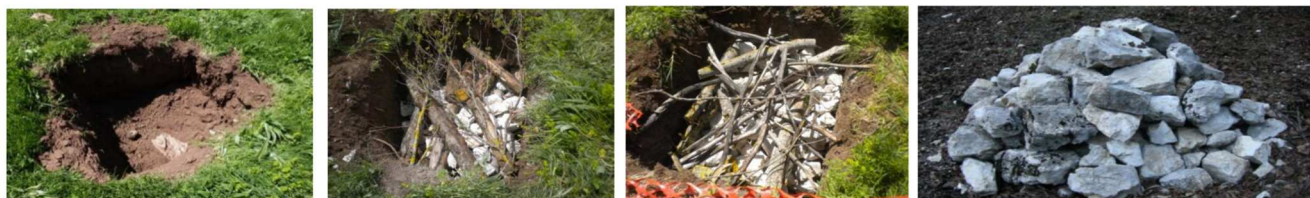
Figura 11. Opera di rifugi per svernamento e protezione per anfibi attraverso lo scavo in sezione obbligata di profondità e larghezza di 50 cm, lunghezza 100 cm riempito con rami, ramaglia, fascine verdi e pietrame reperiti in loco, fino ad un'altezza fuori terra di almeno 50 cm.
